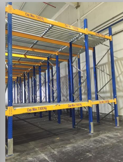
Mantenimiento rack tipo flow-rack
