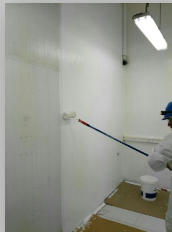
Pintura de muros
