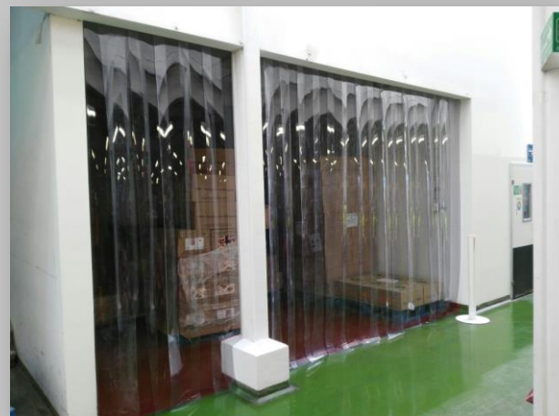
Instalación de lamas
