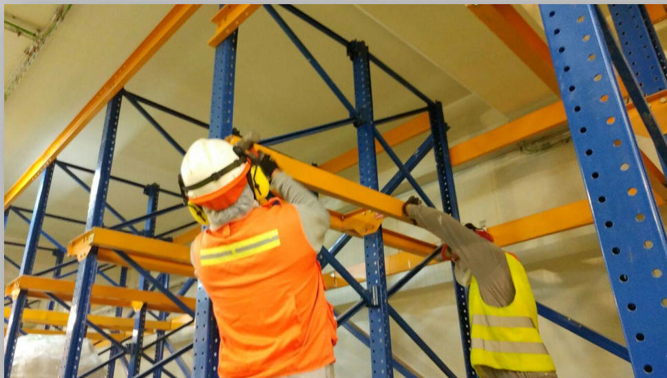
Reparación rack tipo drive-in
