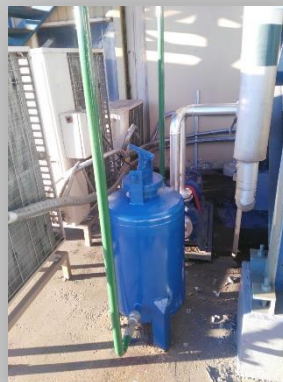
Pintura equipos exteriores
